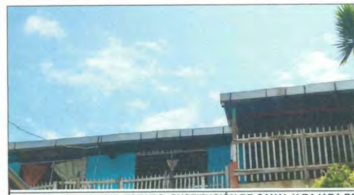
Foto 6: CANAL EN MAL ESTADO, SUSTITUCIÓN DE CANAL Y BAJADA DE AGUA PLUVIAL
